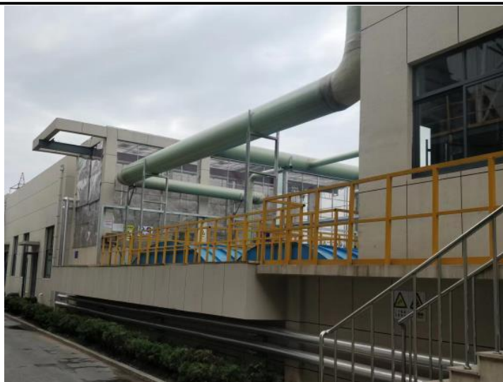
污水处理站（现有）
