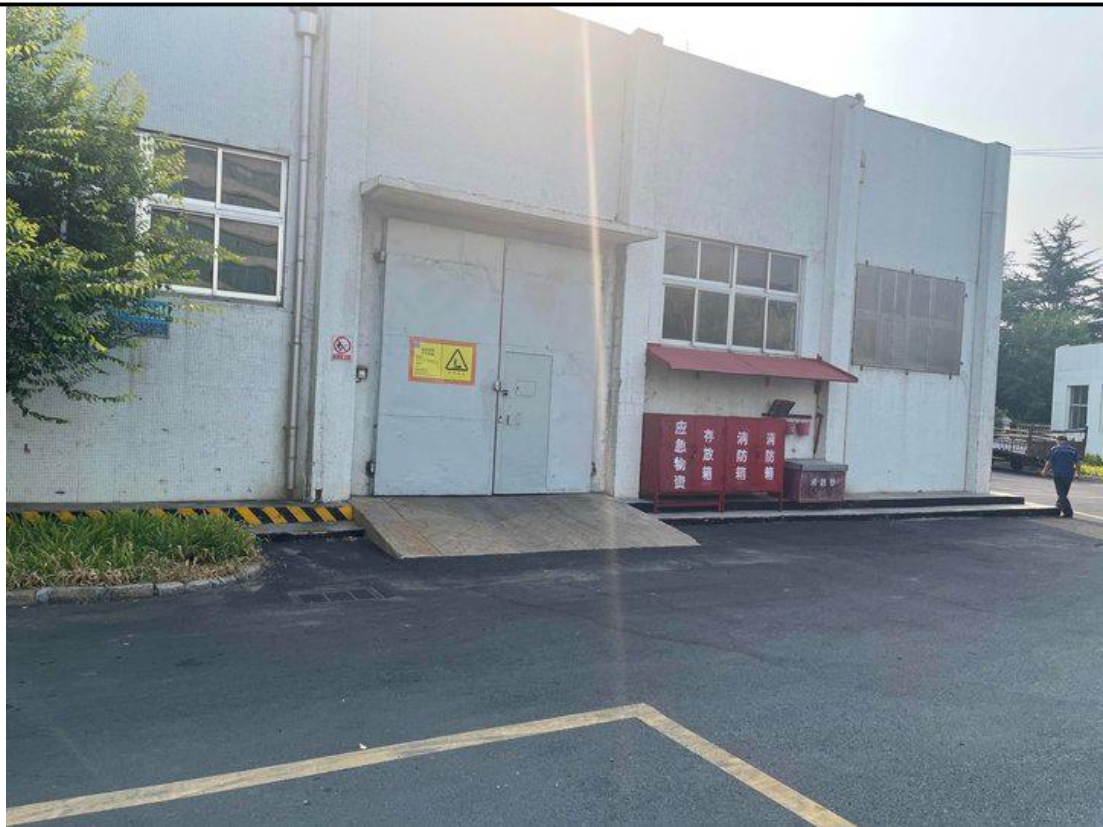
西危险废物贮存室库外标识牌及应急物资
