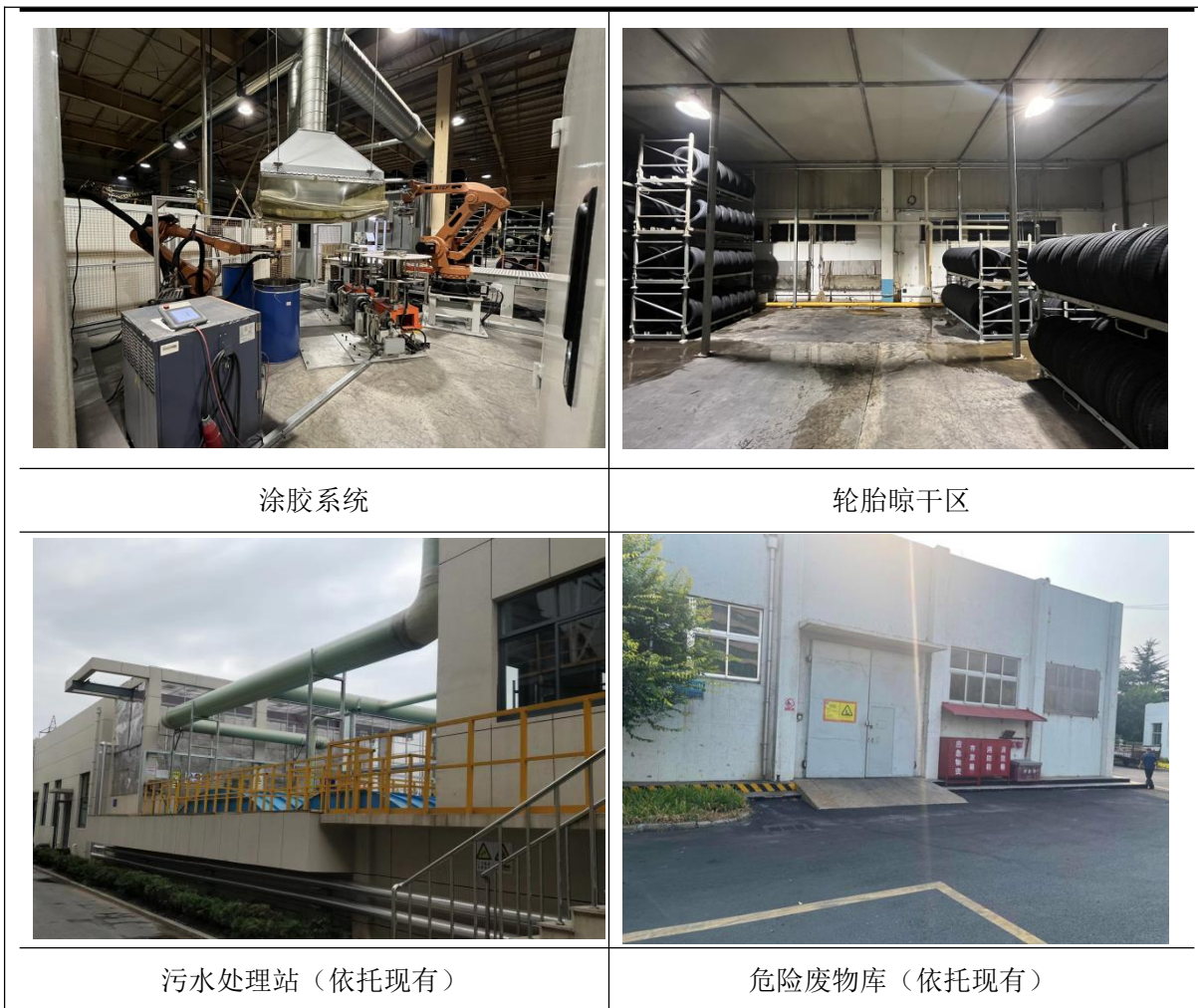
图 2-1 项目现场照片
